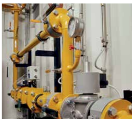
Linea di misura Metering system
