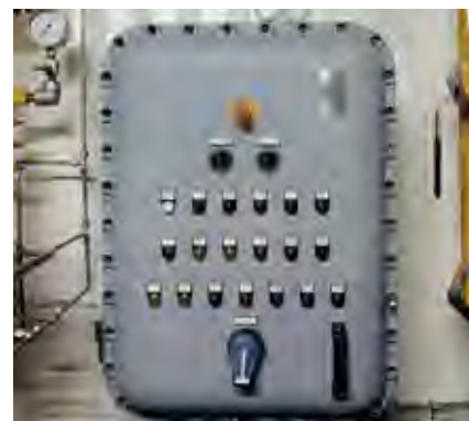
Quadro di comando ATEX EEXD ATEX EEXD control panel
