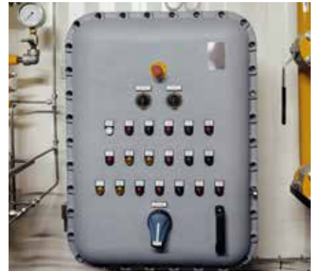
Quadro di comando ATEX EEXD ATEX EEXD control panel
